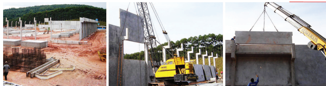
Centro de Detenção Provisória de Jundiaí: construção prossegue em ritmo acelerado
